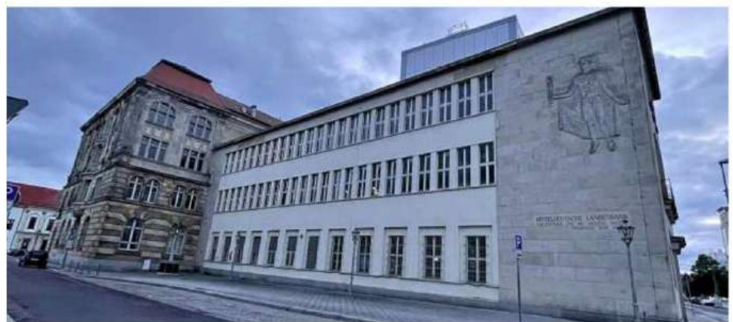
Der Nordflügel des Neuen Rathauses soll saniert werden.
