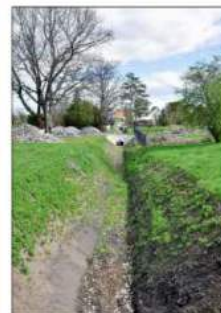
Der Ausbau der Furtlake dient dem Hochwasserschutz. Fotos: K. Kraft
