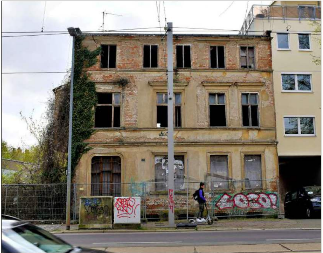
An der Großen Diesdorfer Straße 163, Standort der ehemaligen Seilwerke, soll ein neues Wohnquartier entstehen. Die Stadtverwaltung hat eine Bauvoranfrage für vier Neubauten positiv beschieden.
