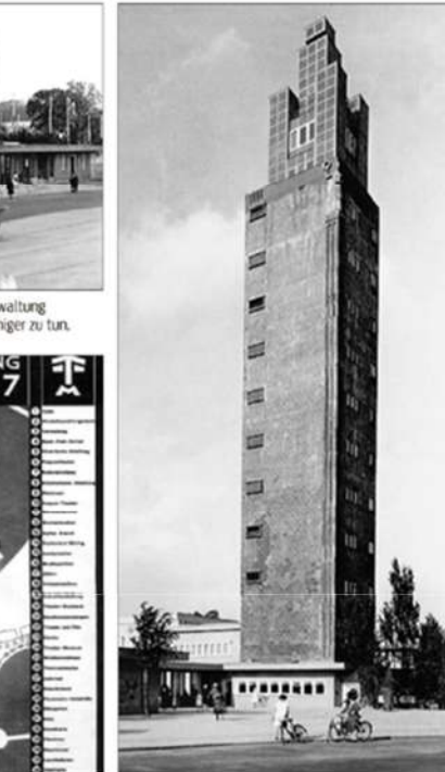
Drei wesentliche Gestaltungsmittel wurden bei den Fassaden genutzt: Klinker, Putz glatt oder als sogenannter Bossenputz sowie Glas.
