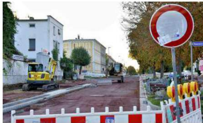
Blick auf die Baustelle in der Königstraße. Seit Juli 2022 gibt es deshalb eine Vollsperrung. Mitte November sollen die Arbeiten fertig sein. FOTOS: KONSTANTIN KRAFT
