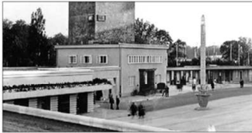
Im ehemaligen Basisbau am Fuße des Albinmüller-Turmes war nur die Verwaltung untergebracht. Sie hatte mit dem Turm beziehungsweise Turmeingang weniger zu tun.
