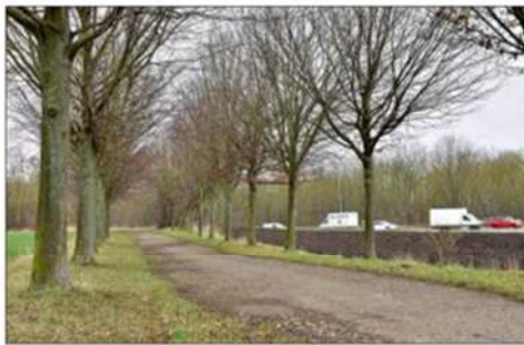
Der Ausläufer der Straße Alt Benneckenbeck endet abrupt am Magdeburger Ring. Eine Brücke könnte eine Passage nach Reform eröffnen.
