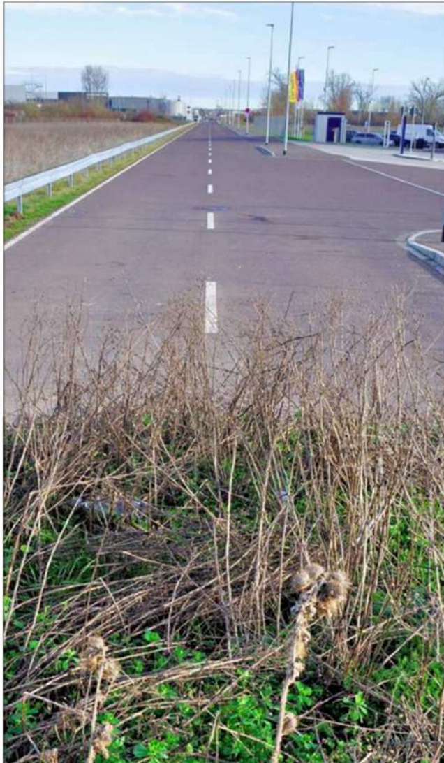
Ende im Gelände: Die Grabower Straße im Gewerbegebiet Nord endet bislang kurz hinter der Einfahrt zum Logistikler Dachser an einem Erdhaufen.
