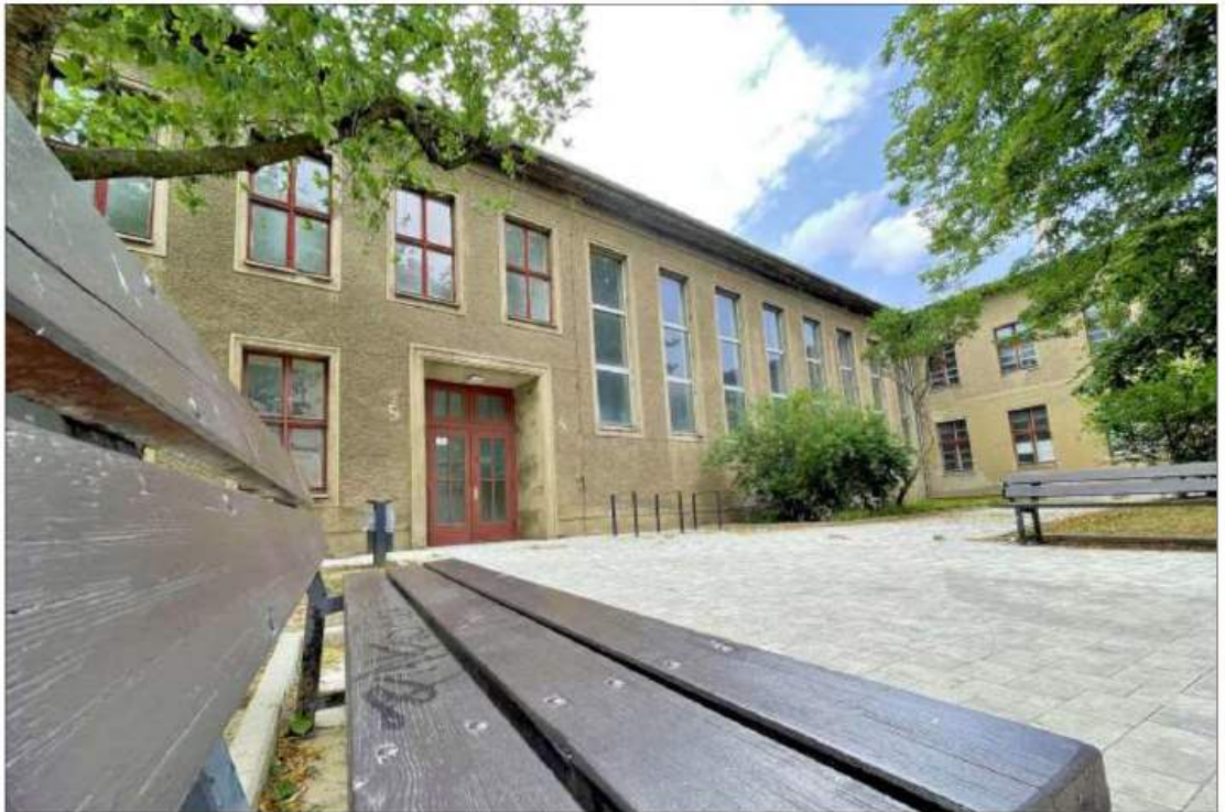
Mit Bänken zum Verweilen und schattenspendenden Bäumen davor wirkt die Turnhalle an der Brandenburger Straße einladend. Doch bis dort der Orchesterprobenraum einziehen kann, muss noch renoviert werden.
