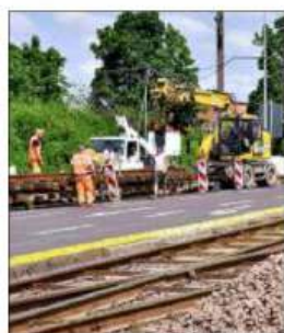
Auf dem August-Bebel-Damm in Rothensee werden neue Schienen verlegt. Foto: Stefan Harter
